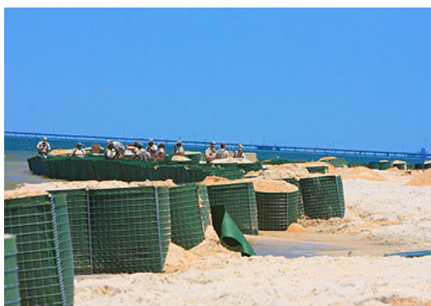
用箱型 Concertainer 构筑的堤坝，内装沙子。
